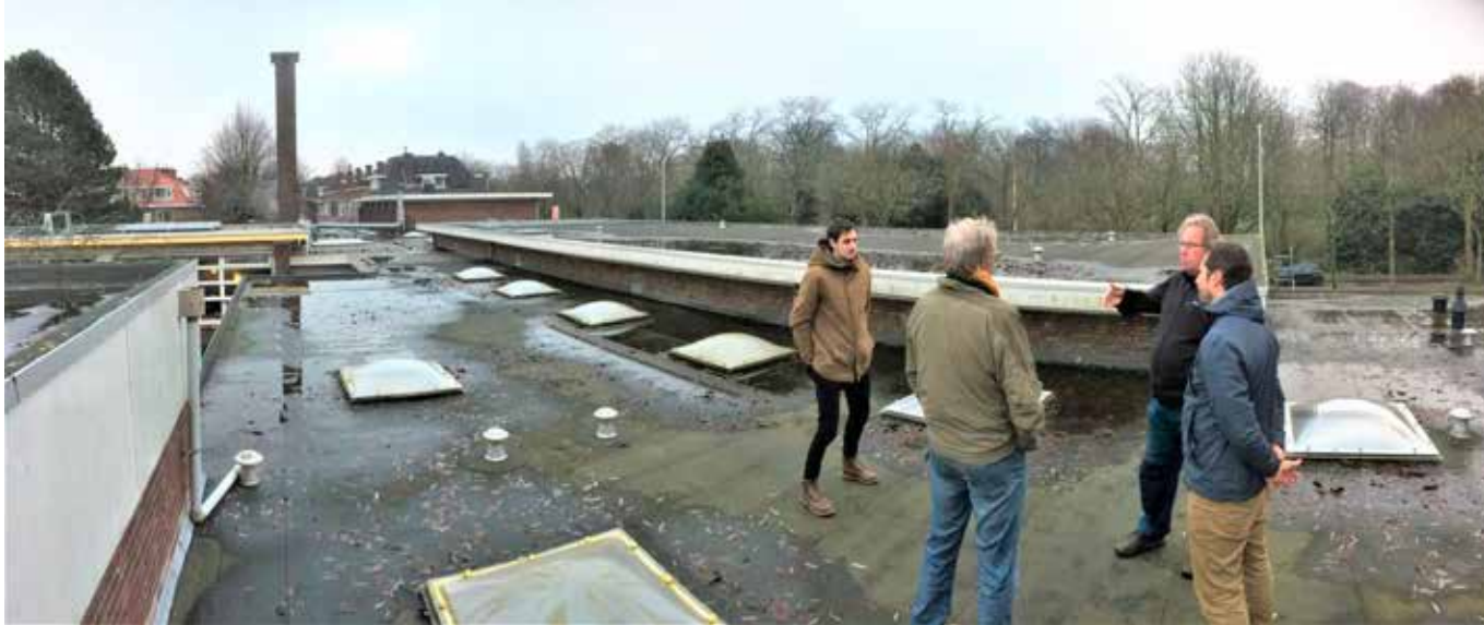
Dak op een woning aan de Mient.
