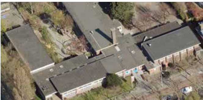
Dak van de Aikido-school aan de Mient 277 (credit: Groene Mient/Sterk op Stroom)
