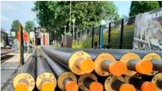
Warmtebuizen van NetVerder in The Green Village in Delft, een Fieldlab voor duurzame innovatie.
